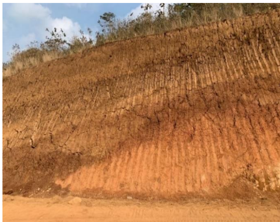
Gambar 14. Singkapan alterasi argilik pada dinding Pit
