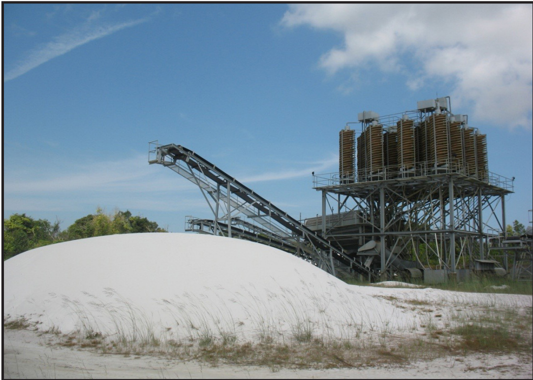
Mesin pengolahan (Humphrey Spiral) Pasir kuarsa di daerah Gunung Seteleng, Kecamatan Penajam, Kabupaten Penajam Paser Utara, Provinsi Kalimantan Timur (Irwan Muksin, 2015)
