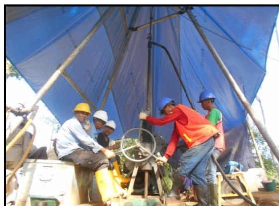
Gambar 2. Kegiatan pengeboran uji geologi menggunakan mesin jenis Sander SD-3C
