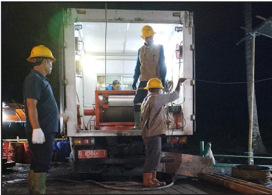
Persiapan *logging* untuk pengukuran temperatur sumur di kedalaman 160 meter
