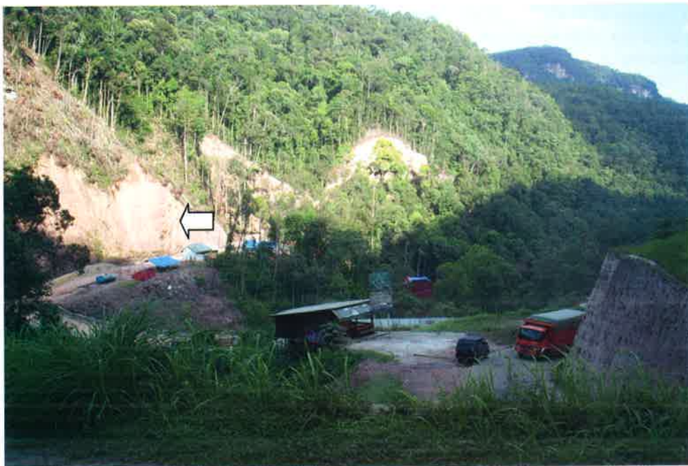
Foto 8. Tampak penggalian batu gamping (tanda panah), untuk pembangunan jalan jembatan, di daerah Kelok Sembilan, Sumatera Barat
