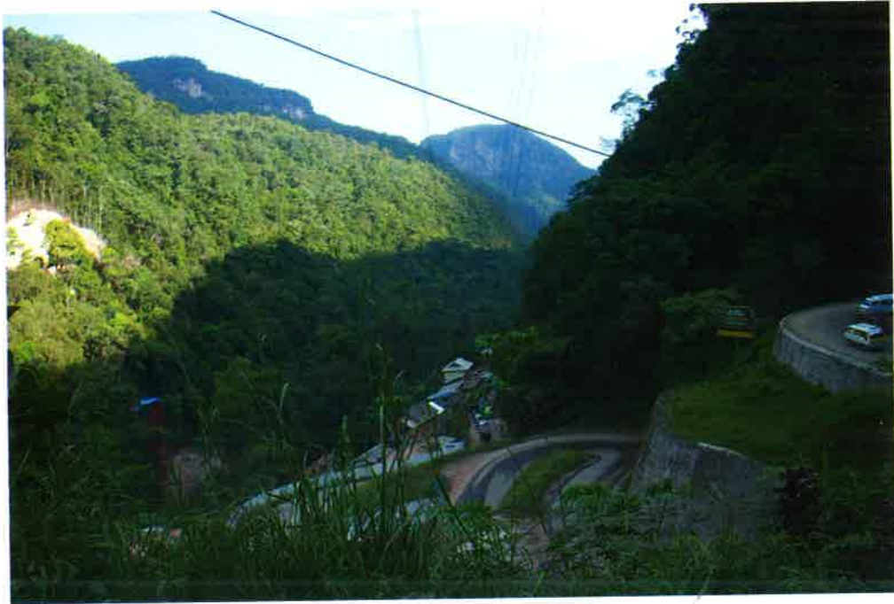
Foto 9. Tampak jalan kelok sembilan, sumatera barat
