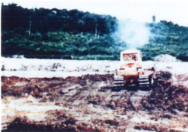
Gambar 9. Reklamasi bekas tambang emas aluvial dengan mengembalikan lapisan tanah penutup berupa lempung, Bungotebo, Jambi (Gurniwa & Suprpto, 1994)
