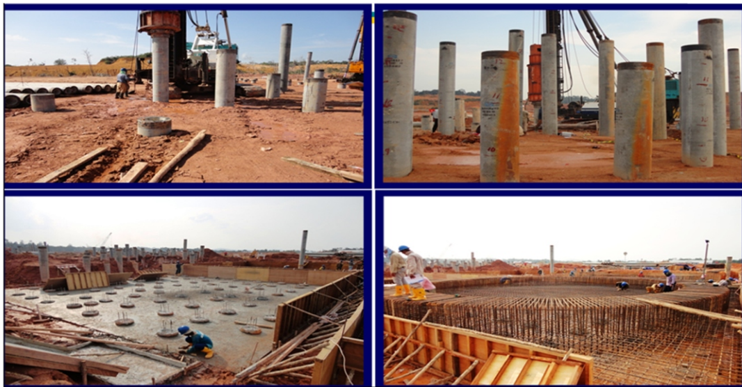
Gambar 2. Pembangunan pabrik CGA tahap konstruksi di Tayan (PT.Antam, 2009)
