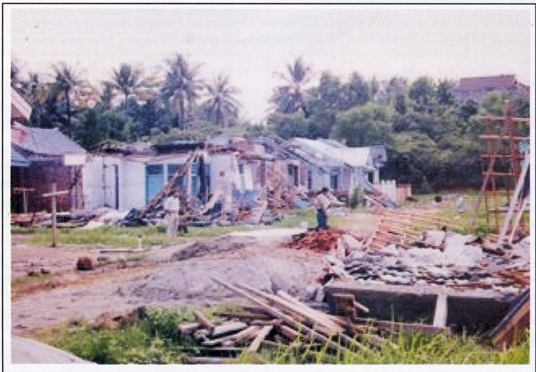
Foto 4. Lokasi perumahan yang hancur akibat guncangan gempa dan tsunami di Kota Nias, Kab. Nias, Sumut.
